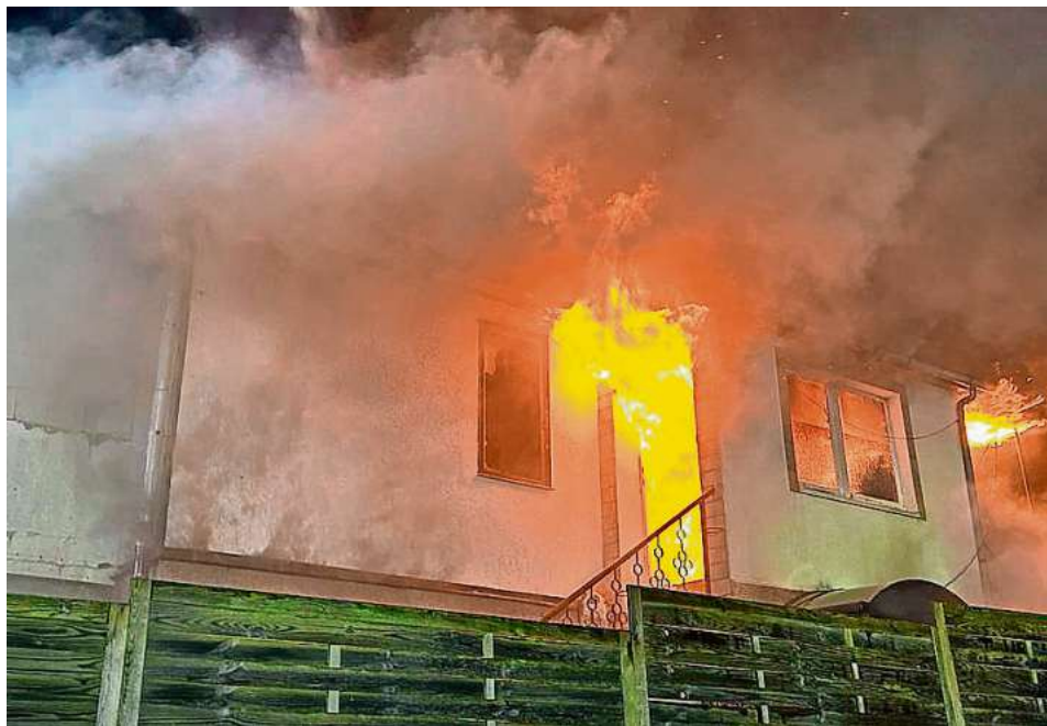
Als die Feuerwehr eintraf, schlugen Flammen aus der ersten Etage.
